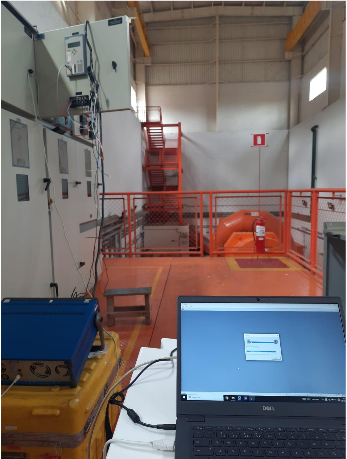
Figura 41 - Estabelecendo comunicação com o relé de proteção
