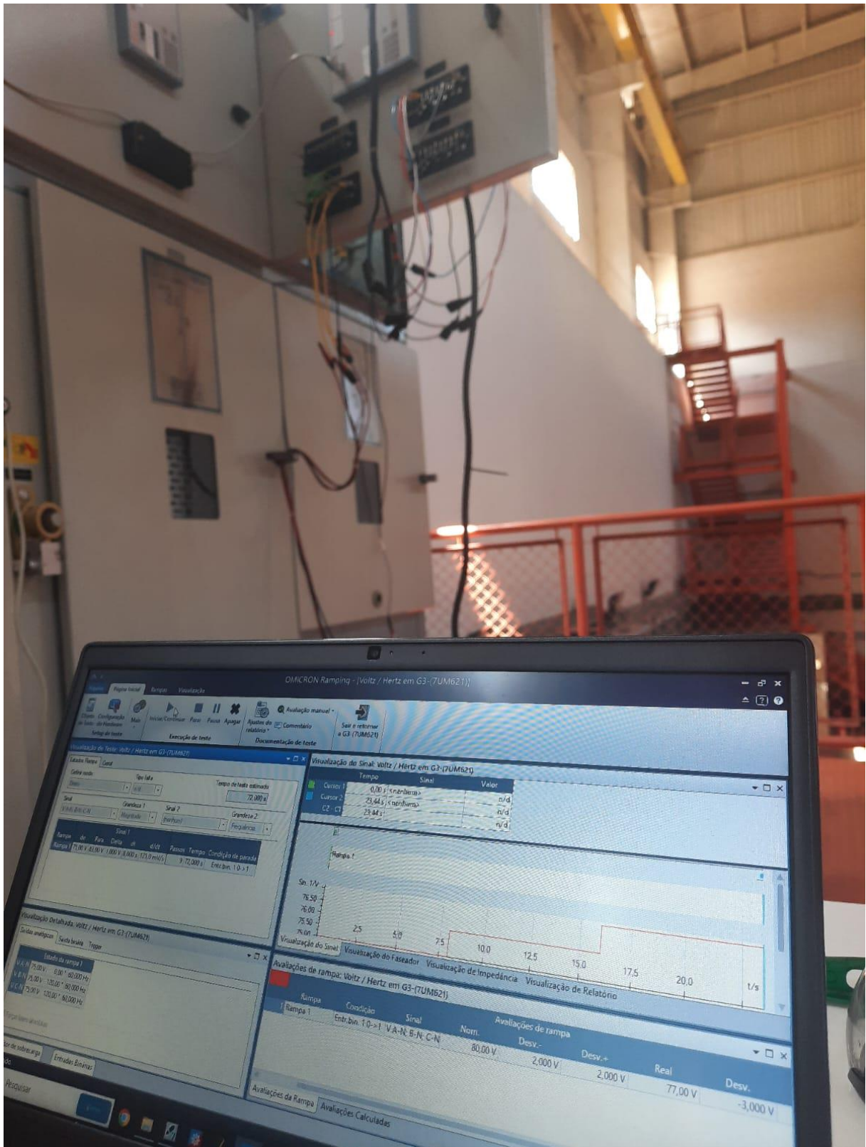
Figura 42 - Teste de proteção em andamento
