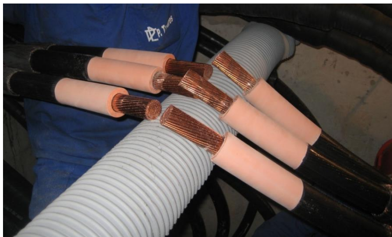
Figura 18 – Cabos isolados preparados para emenda
