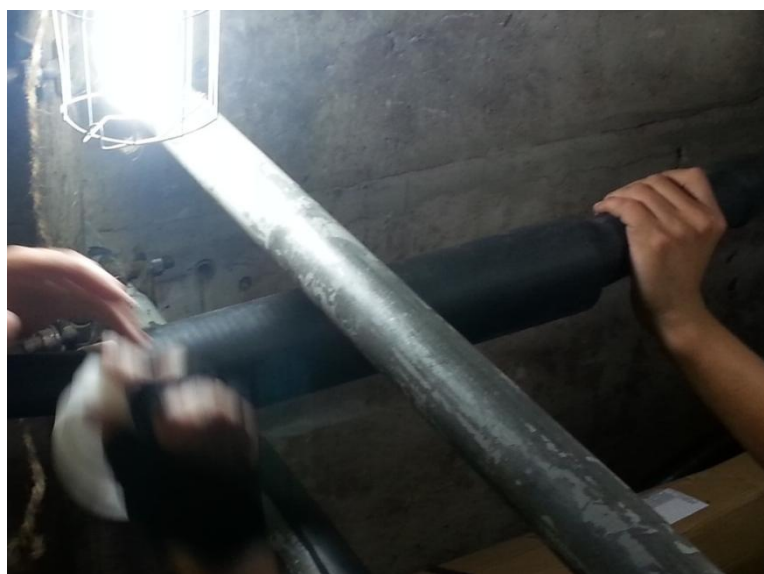
Figura 31 – Aplicação da camada externa sobre a meia metálica
