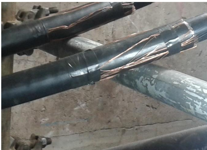
Figura 20 – Dobra efetuada na blindagem do cabo
