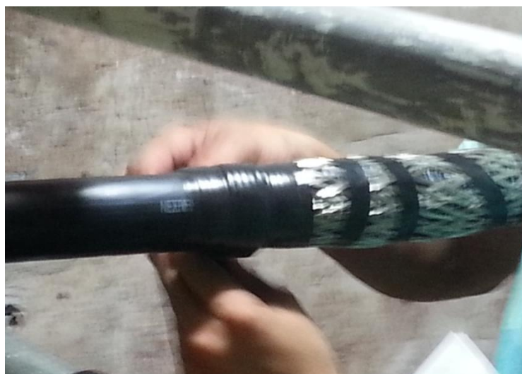
Figura 30 – Aplicação de fita isolante sobre as molas de aço
