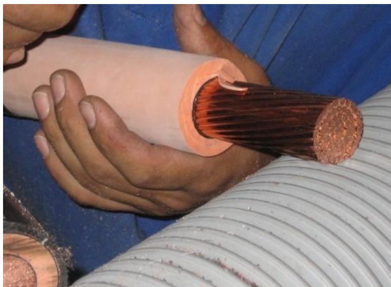
Figura 22 – Retirada de parte da camada isolante
