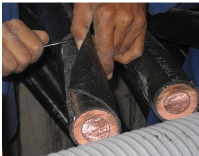
Figura 19 – Retirada da capa externa do cabo
