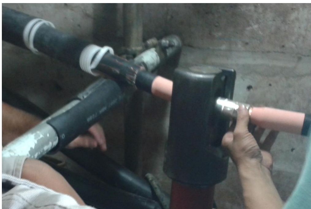
Figura 25 – Utilização do alicate de pressão para fixação do conector
