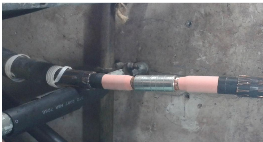
Figura 24 – Conector ajustado nos condutores
