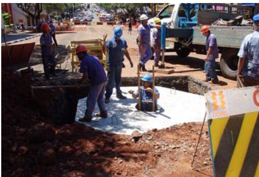
Figura 14 – Mini poço de inspeção
