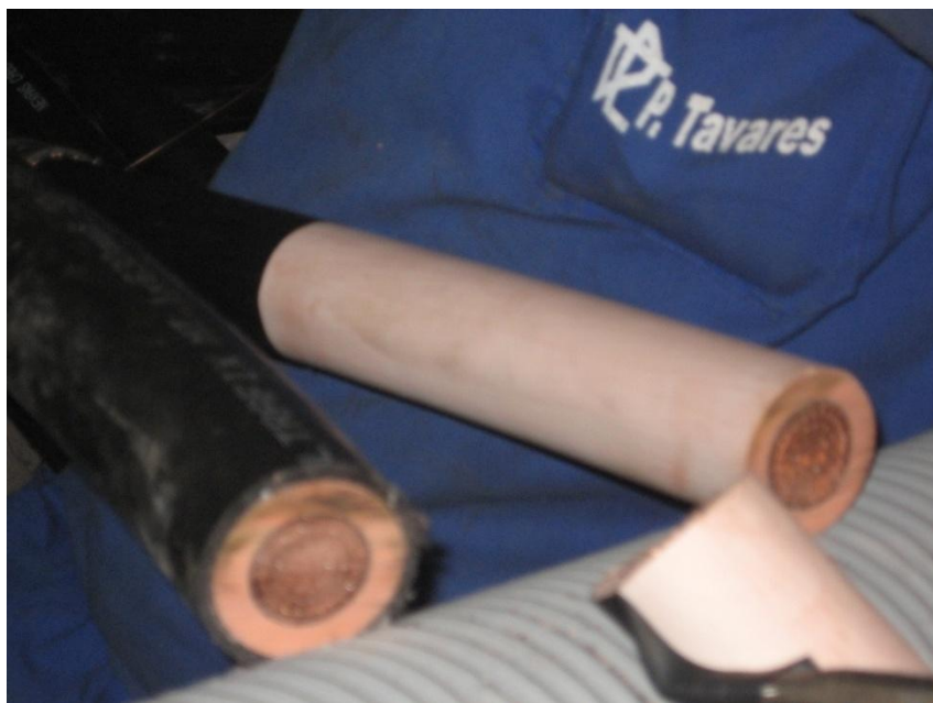
Figura 21 – Cabo após a retirada da camada semicondutora
