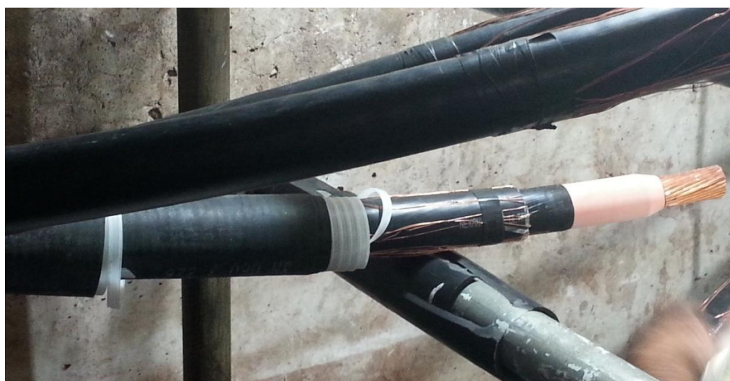
Figura 23 – Tubos de proteção inseridos no cabo
