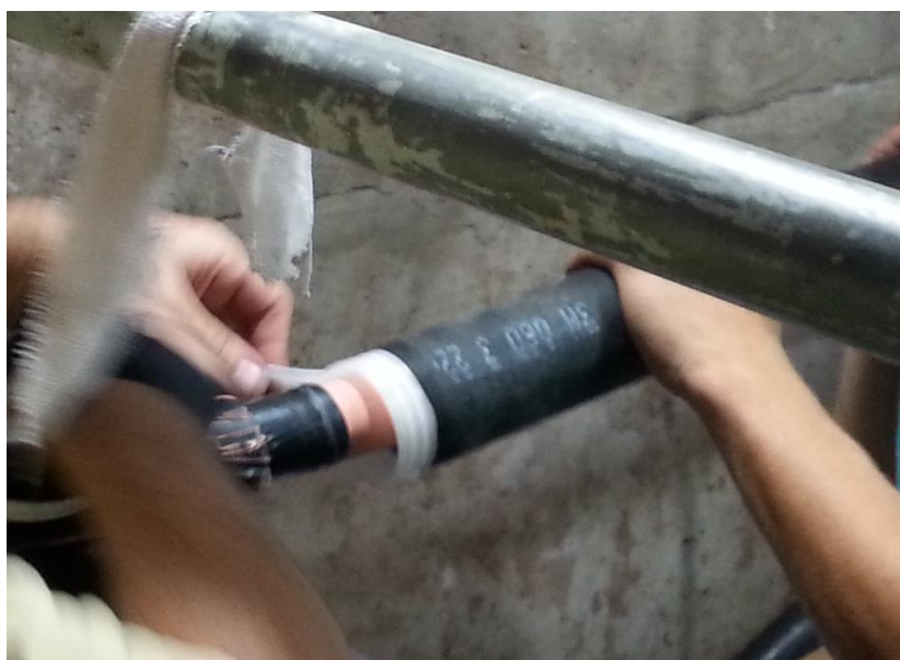
Figura 27 – Aplicação do tubo isolador
