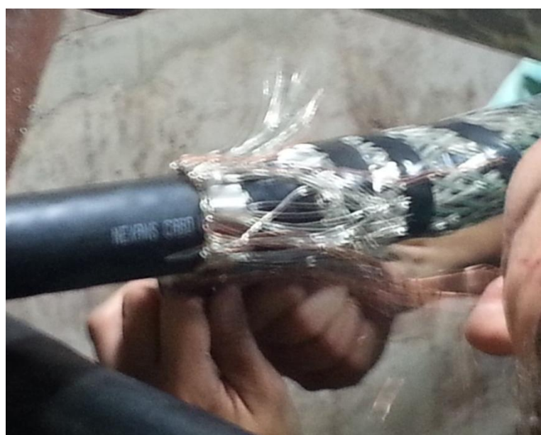
Figura 29 – Ajuste da meia metálica sobre a mola de aço
